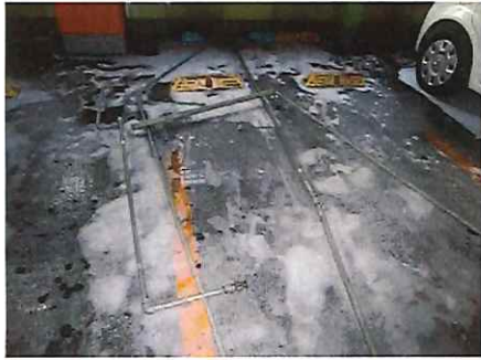
泡流出事故の例
