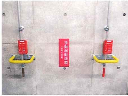
手動起動装置に保護ガードを設置
